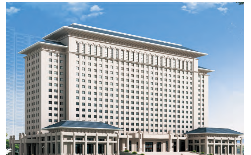
甘肃省委办公大楼
